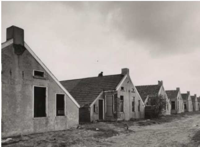
Foto van de huisjes vlak voor de sloop. ©2015 Beeldbank Groningen
